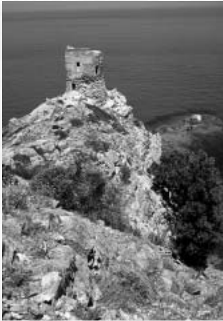
La tour d'Agnellu, à quelques encablures de Barcaggio.
